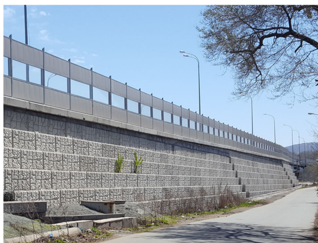
Рис. 3. Подпорное сооружение на трассе Де-Фриз – Патрокл (Приморский край)
