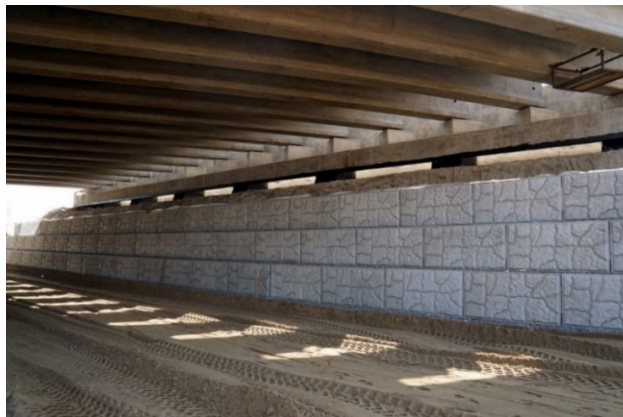
Рис. 5. Крепление устоев моста (а/д М 12, ПК 482, Московская обл., пос. Большие Дворы)
