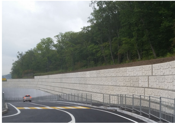
Рис. 4. Подпорная стена на автомобильной дороге – ул. Маковского (г. Владивосток)
