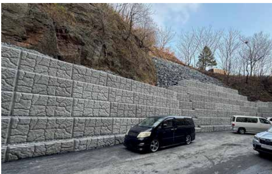
Восстановление подпорной стены, пострадавшей при обрушении 24 августа 2024 года на Славянской ул., Владивосток
