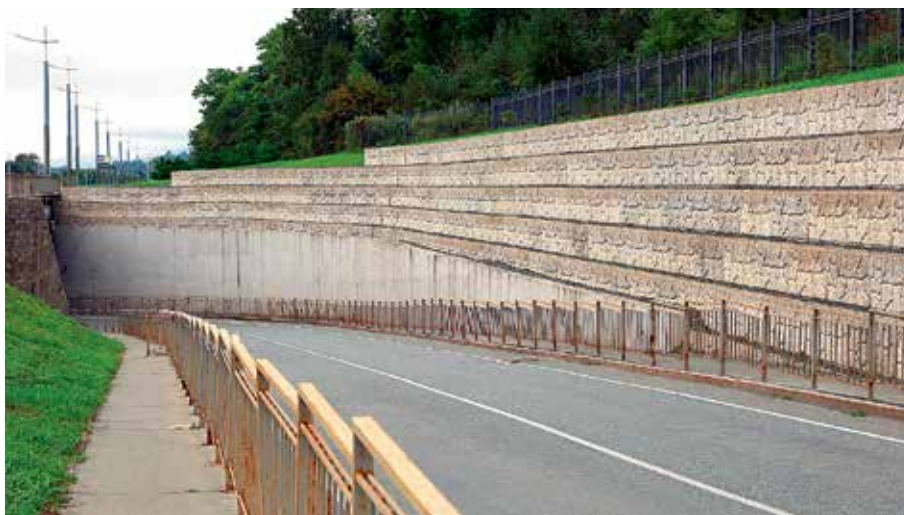
Подпорная стена на улице Маковского, Владивосток
