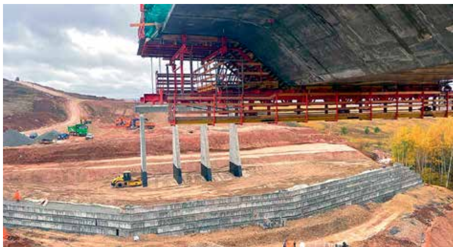
М-12, 7-й этап, мост через Осипов овраг
