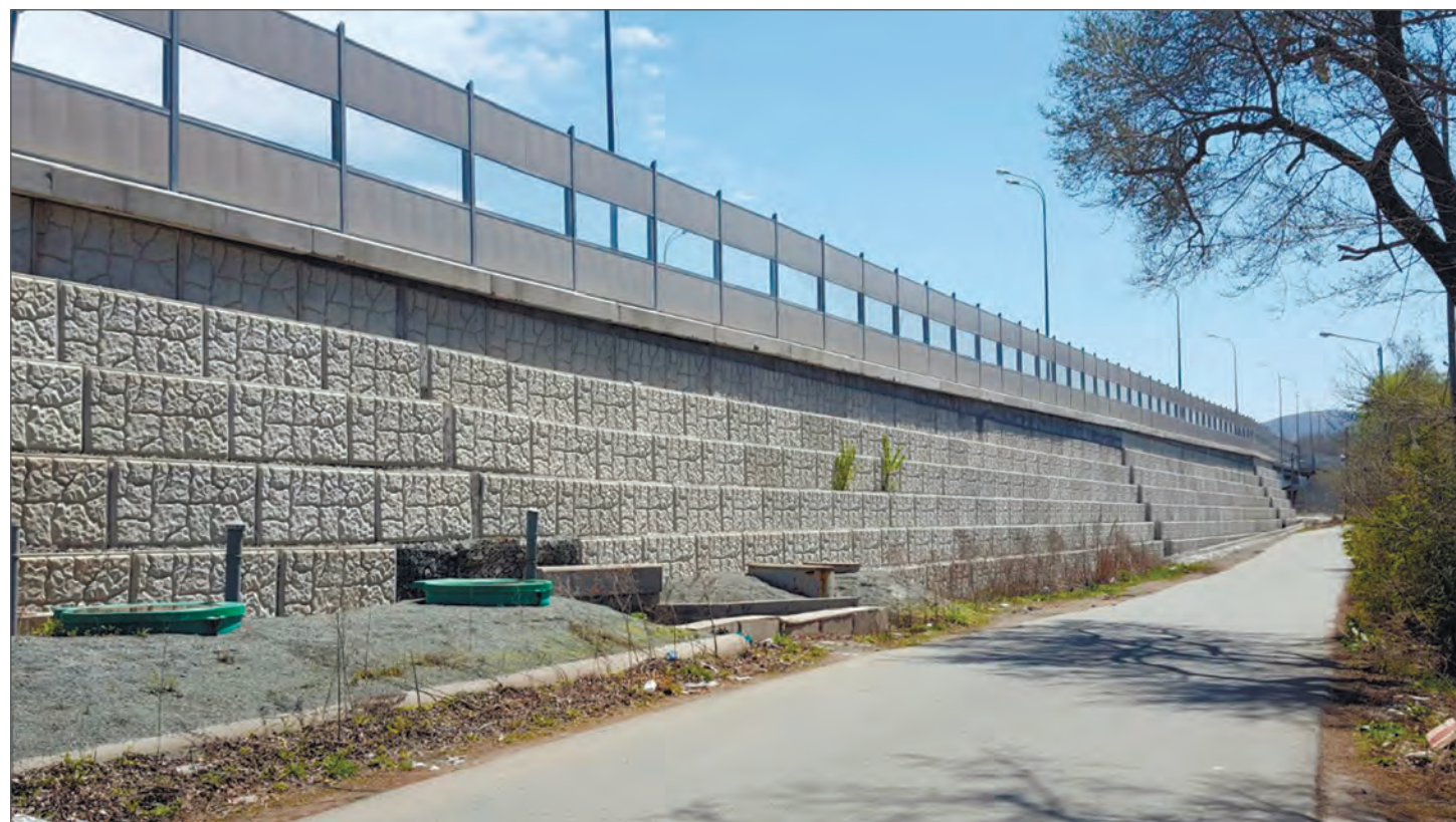
Рис. 2. Крепление дорожной насыпи, трасса Де-Фриз – Патрокл
