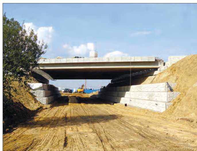
Рис. 3. Путепровод, 0-й этап трассы М-12 (пос. Большие Дворы)
