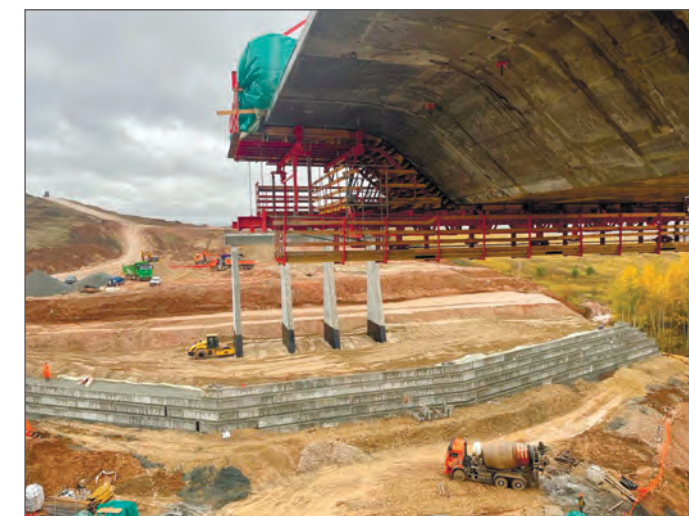
Рис. 5. Устой моста через Осипов овраг, 7-й этап трассы М-12
