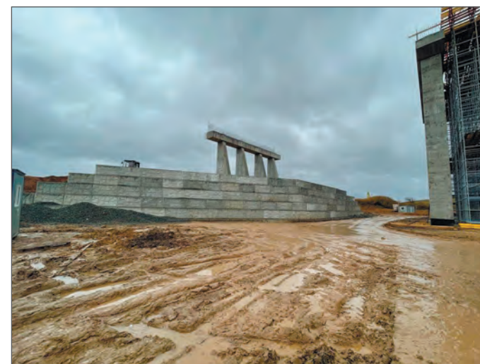
Рис. 4. Устой моста через р. Шаратка, 7-й этап трассы М-12
